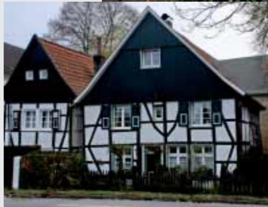
Gegensatz zu der älteren Ständerbauweise, deren Wände über die gesamte Haushöhe mit oft bis in den Dachansatz „schiessenden“ Ständern konstruiert sind. Im Innenraum trennen dann waagerechte Balkenlagen Ober- und Untergeschosse (sog. Geschossbauweise).
